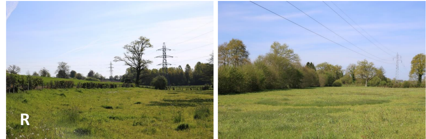
Photo 54 : Passage d'une ligne haute tension au-dessus du site d'étude
