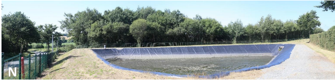
Photo 52 : Bassin de rétention d'eau
