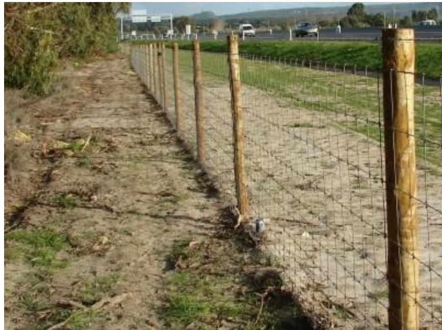
Photo 57 : Exemple de clôture avec grillage mouton et piquets en bois
