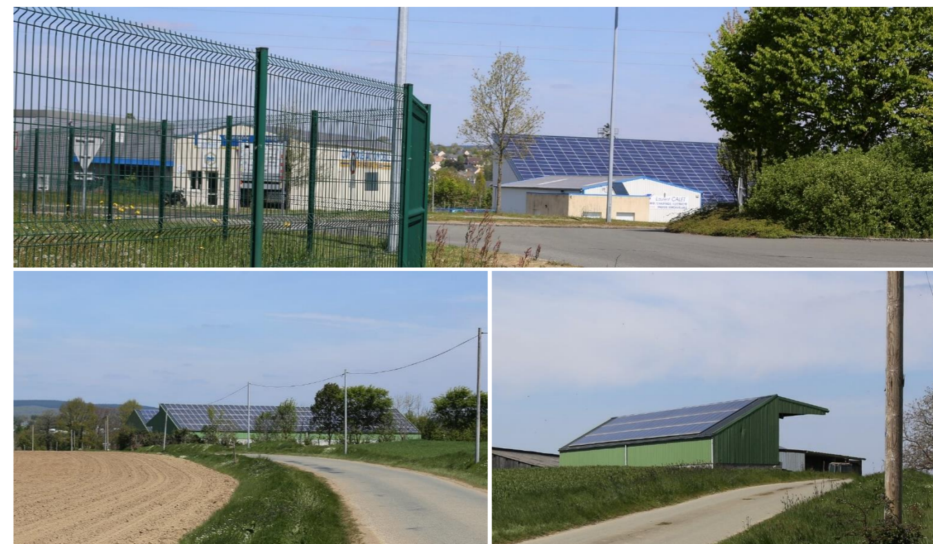
Photo 30 : De nombreuses installations photovoltaïques de toitures sont présentes au sein du territoire étudié
